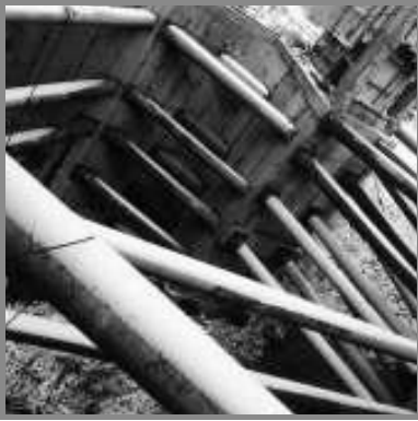
BORU DESTEK İMALATLARI
